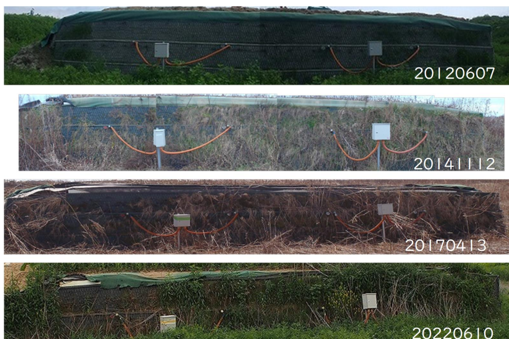
写真-1 補強土壁の植被率の変化
