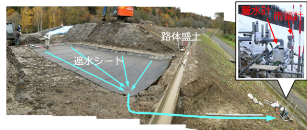
図-9 降雨浸透量調査施設の設置状況 (盛土法面部)
