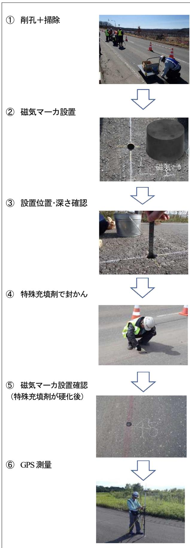
図-4 磁気マーカの施工手順
