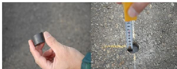
写真-1 磁気マーカ埋設状況
