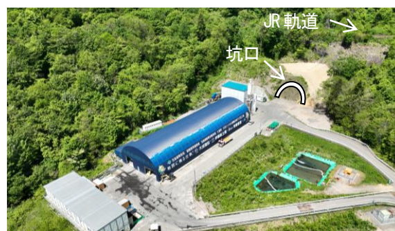
写真-1 峠下工区トンネル坑口
