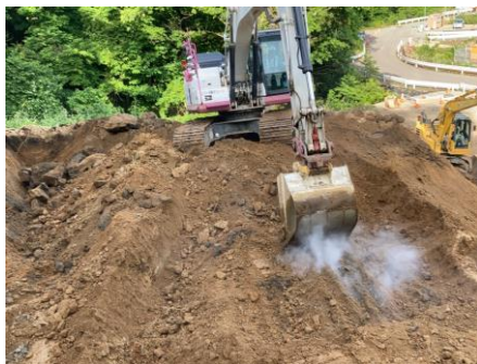
写真-2 硬質地山掘削状況
