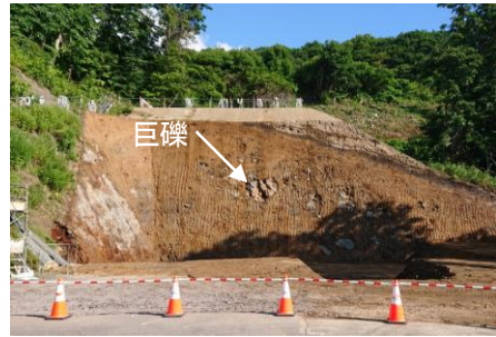
写真-4 坑口切土完了状況
