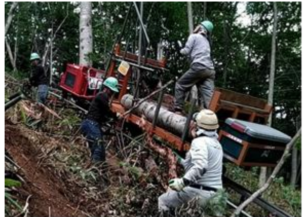
図-4 モノレールによる施工状況
