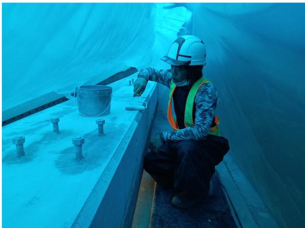
写真4 シラン系表面含浸材の塗布の様子
