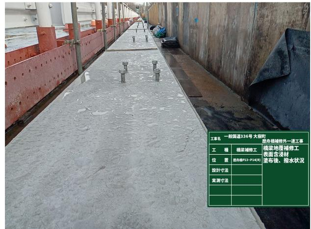
写真5 施工後のコンクリート表面の撥水状況
