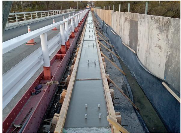
写真-1 地覆コンクリート打設完了時の状況
