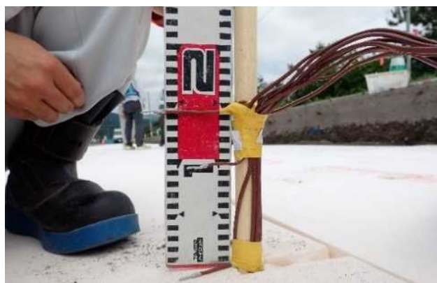
写真-2 熱電対温度計設置状況
