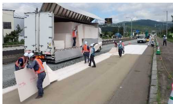
写真-1 断熱材敷設状況
