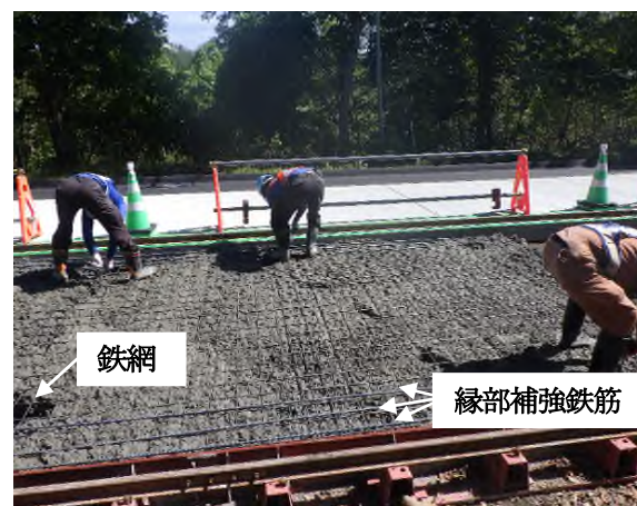
写真-2 鉄網および縁部補強鉄筋の設置
