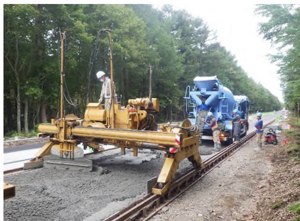
写真-5 試験施工箇所の施工状況
