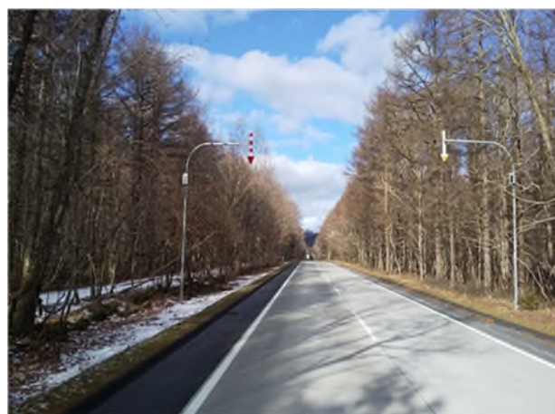
写真-6 試験施工箇所完了後
