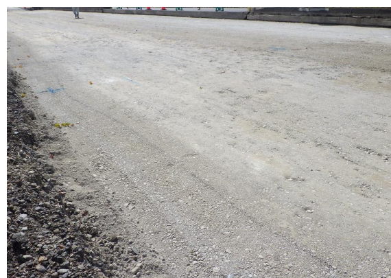
写真-2 転圧後の路盤面の状況
