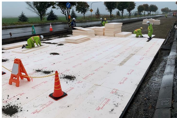
写真-1 断熱材の設置状況
