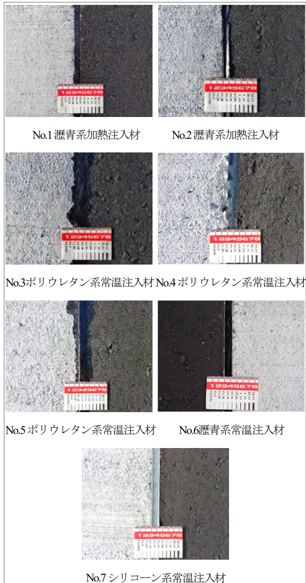
写真-7 コンクリート舗装の縦目地部の施工状況
