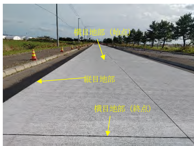
写真-3 縦目地部・横目地部（一般国道227号北斗市本郷）
