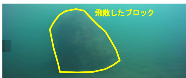
図-8 遠別漁港南防波堤周辺（水中ドローン）
