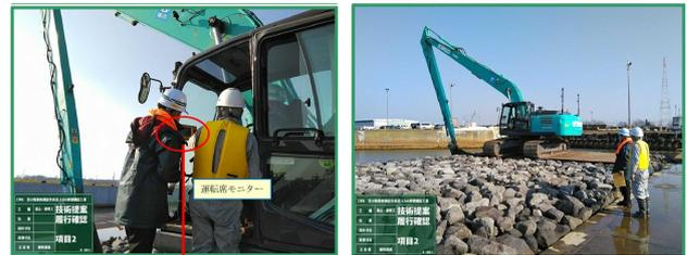
図-10 3Dマシンガイダンスシステムによる均し作業
