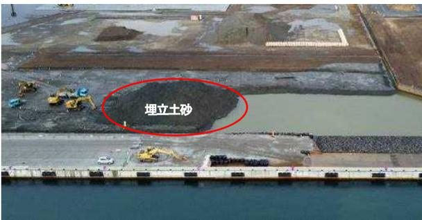
図-7 一次運搬した土砂の堆積状況
