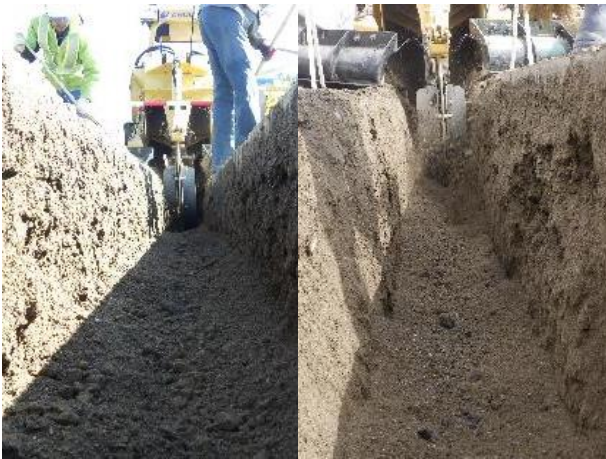
写真4 掘削後（左：一次掘削、右：二次掘削）
