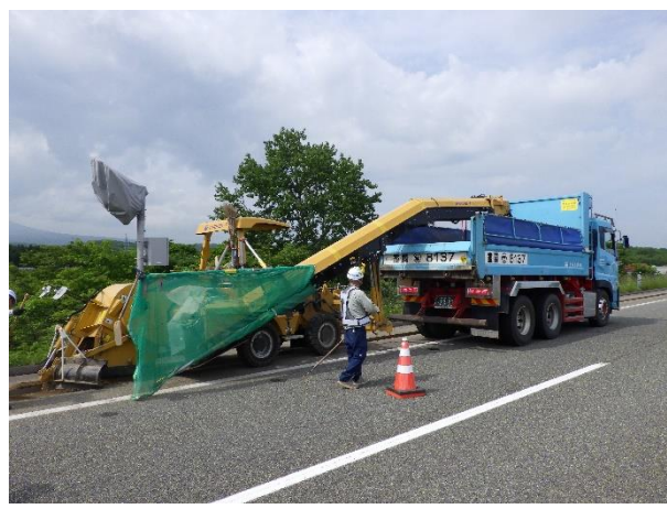
写真-3 トレンチャー掘削状況
