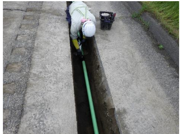
写真5 配管敷設状況
