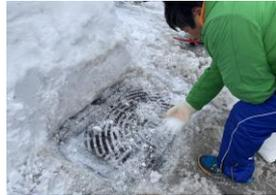
写真-9 流雪溝開閉口に凍結防止剤を散布
