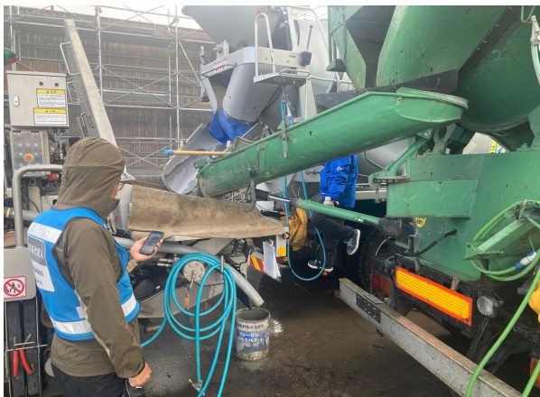
写真-2 現場での it-Concrete 活用状況
