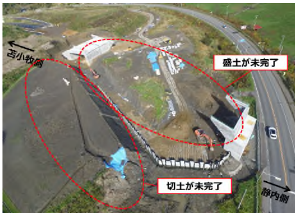
写真-1 新冠ICの施工状況（令和5年10月時点）
