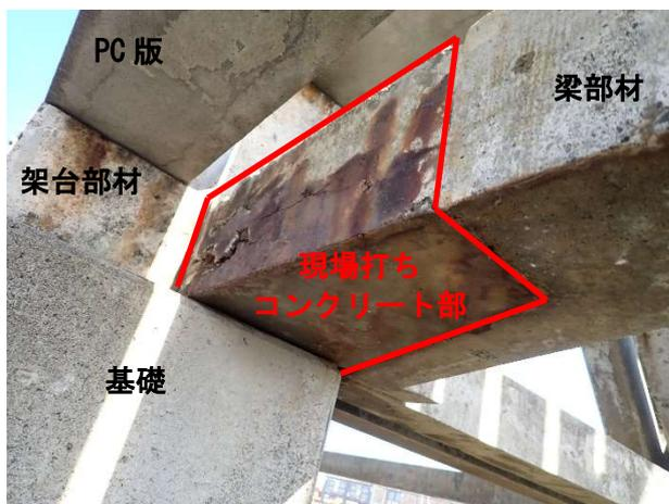
写真-2 現場打ちコンクリート部の劣化状況
