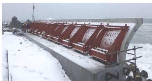
写真8 上部フレア構造の施工状況
