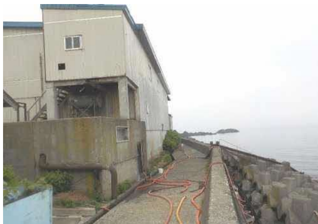
写真6 護岸背後の建物の立地状況②
