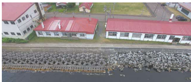
写真5 護岸背後の建物の立地状況①
