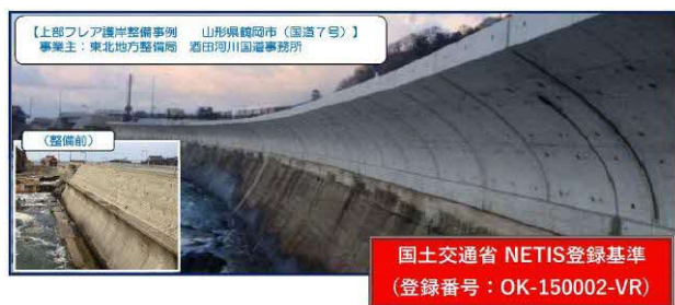
写真-7 上部フレア整備事例 1)
