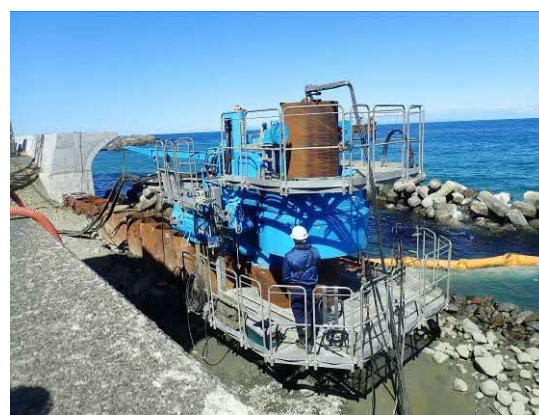
写真9 杭打設(回転切削圧入工法)の施工状況
