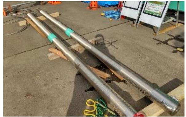
写真-2 挿入する補強鋼材
