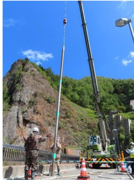
写真-6 補強鋼材挿入状況
