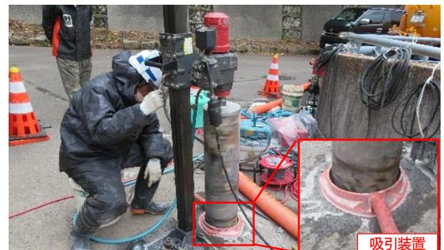
写真-3 ボーリング削孔状況
