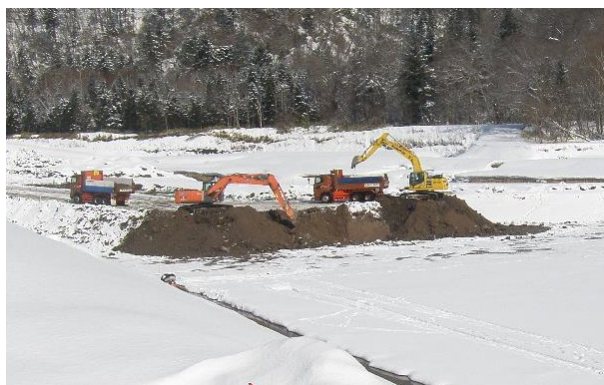
図-6 堆砂土掘削工事 (H29)
