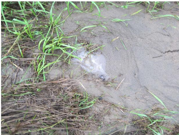
写真-1 川裏側の水路底で確認された噴砂
