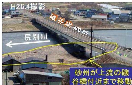
写真-5 導流堤建設後の砂州の移動状況
