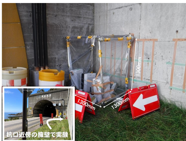
写真-2 試験施工の様子（増毛、コンクリート面に布テープを貼って仕切った枠内がシラン系表面含浸材塗布範囲）
