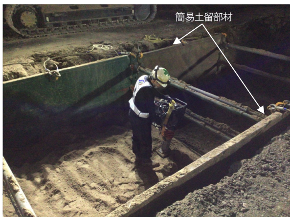
図-17 簡易土留めによる日々埋め戻し作業
