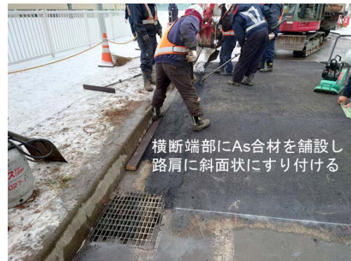
図-19 横断端部の路肩すり付け
