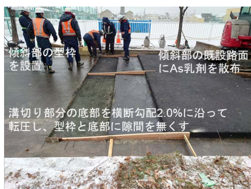
図-13 傾斜部における型枠の設置とAs乳剤の散布
