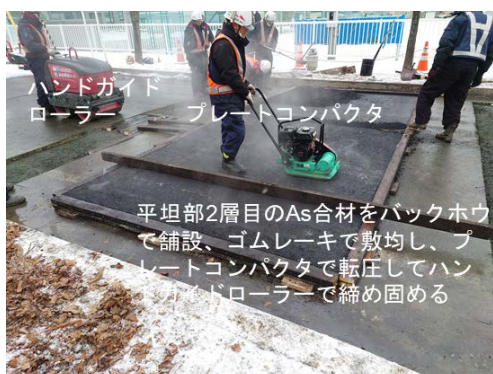
図-10 平坦部2層目へのAs合材の舗設
