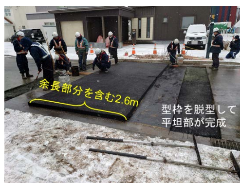
図-11 平坦部の出来形
