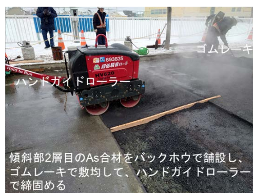
図-16 傾斜部2層目のAs合材の舗設
