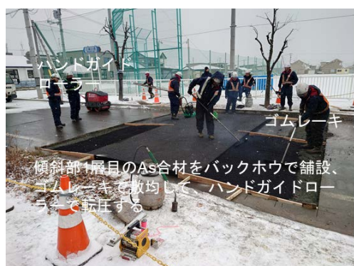
図-14 傾斜部1層目のAs合材の舗設
