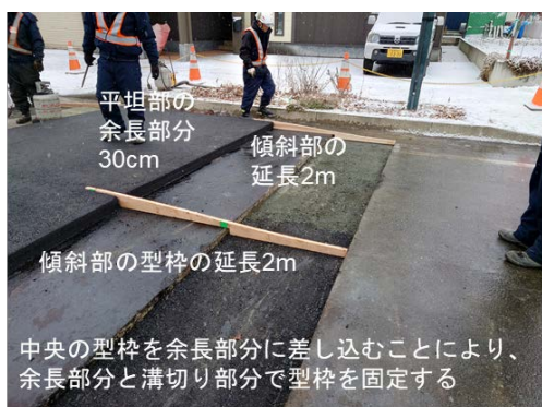
図-22 平坦部の余長部分を活かした傾斜部の型枠の固定
