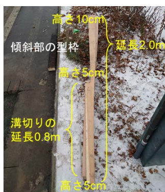
図-12 傾斜部の型枠の形状
