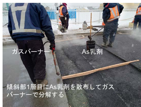
図-15 傾斜部1層目へのAs乳剤の散布
