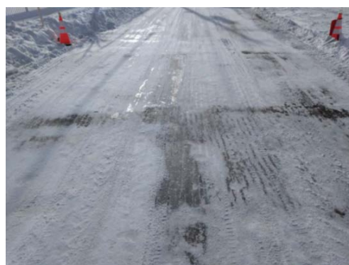
図-26 除雪作業後の供試体の状況（傾斜部）
