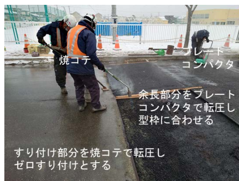
図-17 余長部分の転圧、すり付け部分のゼロすり付け
