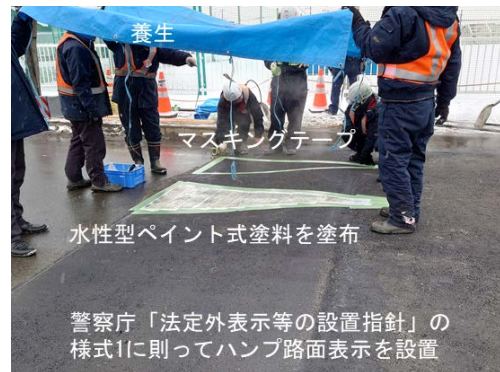
図-20 ハンプ路面表示の塗料塗布
