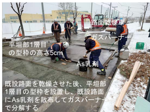
図-7 既設路面へのAs乳剤の散布
