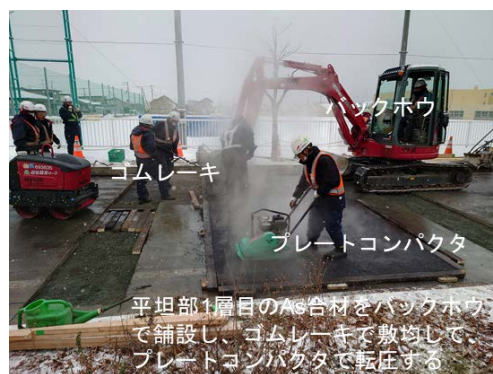
図-8 平坦部1層目のAs合材の舗設
