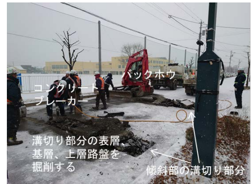
図-4 溝切り部分の舗装版取り壊し
