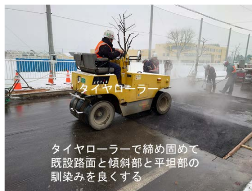
図-18 傾斜部と平坦部の締め固め
