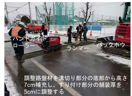
図-6 すり付け部分の舗装厚の調整
