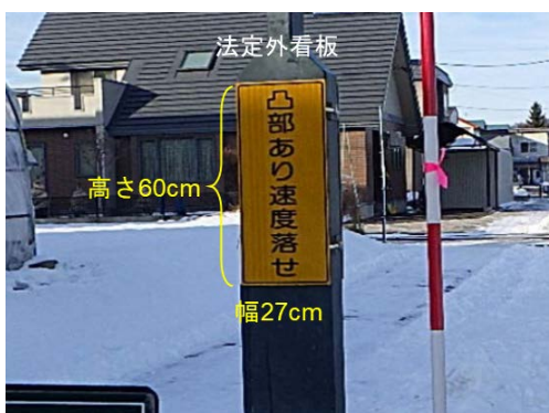
図-24 ハンプを知らせる法定外看板の作成と設置
