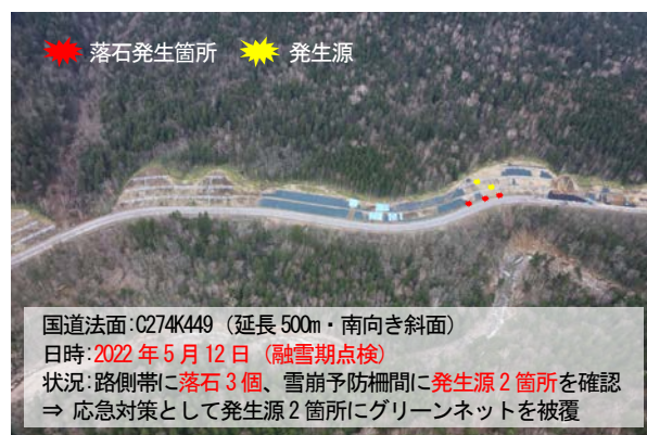
写真-1 調査地の法面全景
