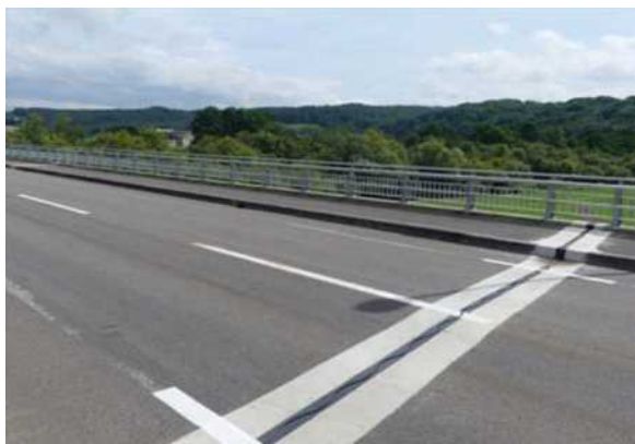
写真-2 後打 Co 立上の事例
