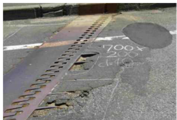
写真-4 As舗装接続の再補修の事例
