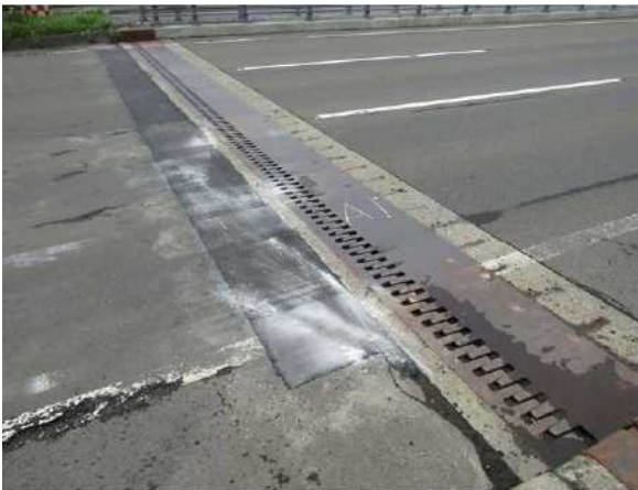
写真-7 後打ちCo立上の補修事例
