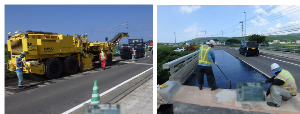
(a) 舗装切削撤去
