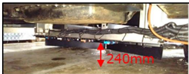
（写真-1 車両側のアンテナ設置状況）
