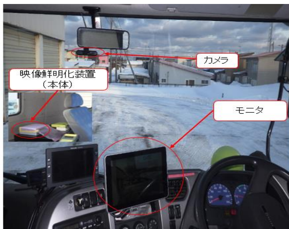
写真-1 除雪トラック設置状況 (AI 搭載型)
