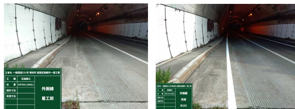
写真-9 トンネル内の区画線の復旧 (左：着工前、右：着工後)
