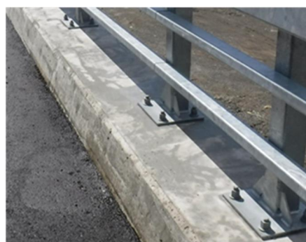
写真-4 G 橋の表面含浸材塗布直後の状況
