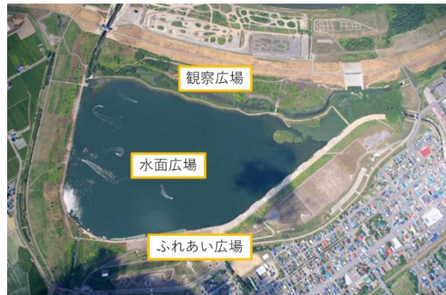
図7 砂川遊水地の全体写真
