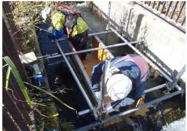
写真-2 人力での誘導水路設置状況
