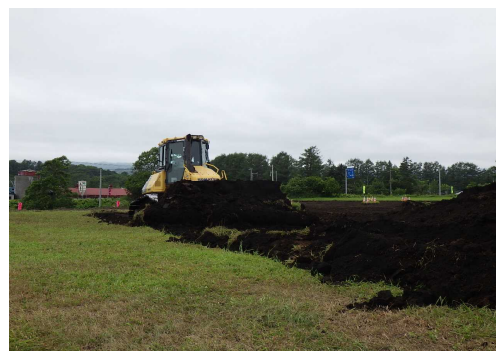
写真-1 整地工施工状況
