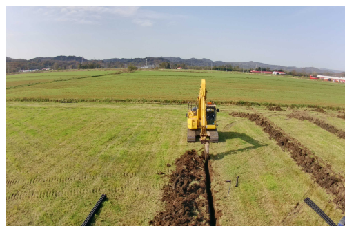
写真-2 暗渠排水工施工状況
