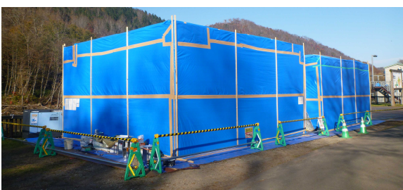
写真-2 防寒囲い状況
