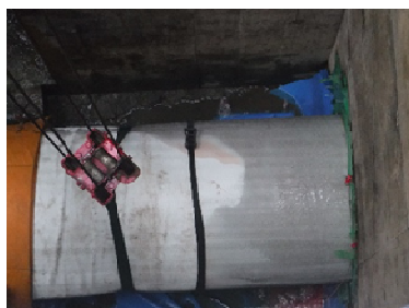
写真-1 ホースライニング工法の施工状況
