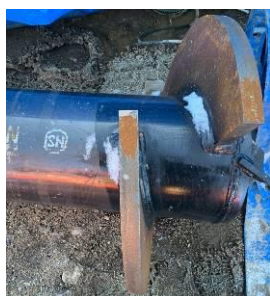
写真-1 鋼管杭先端部
