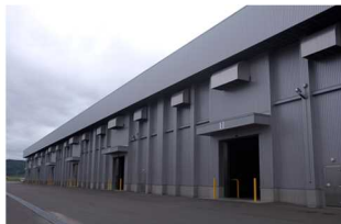
写真9 冷蔵貯蔵施設外観
