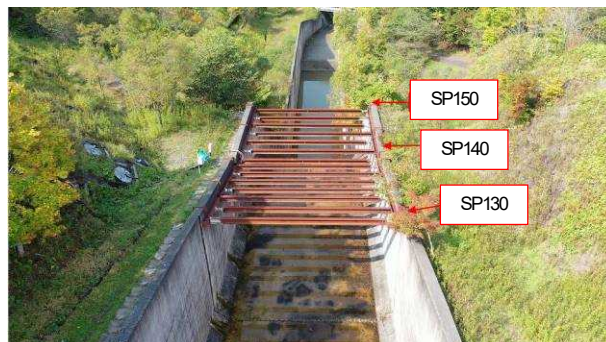
写真-1 洪水吐改修範囲（施工前）
