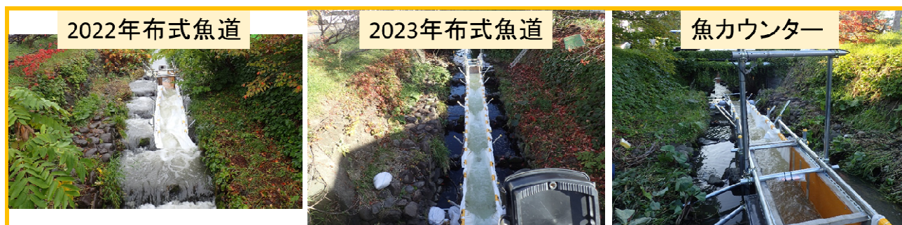
図-3 精進川下流部においてサケ科魚類の遡上数計測のために設置された布式簡易魚道と魚カウンター
