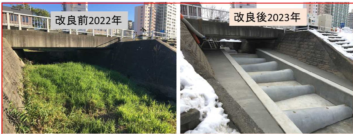
図-2 精進川合流部における魚道改良箇所
