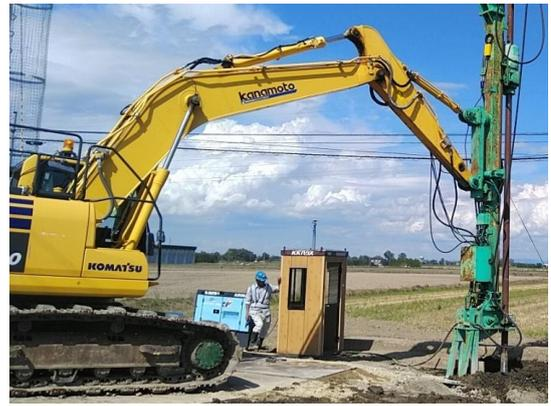
図-7 地盤改良機設置状況
