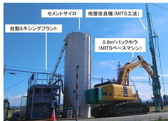
図-5 機械・プラントの配置図
