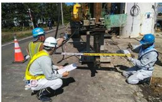
図-10 攪拌翼の径の確認状況
