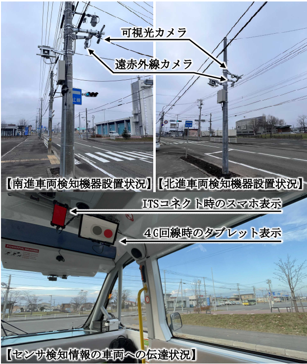
図-8 機器類の設置状況
