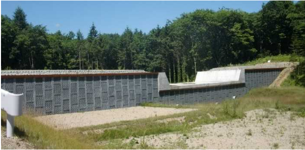
写真2 小泉の沢川1号砂防堰堤
