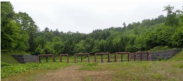
写真3 小泉の沢川左支川流木捕捉工
