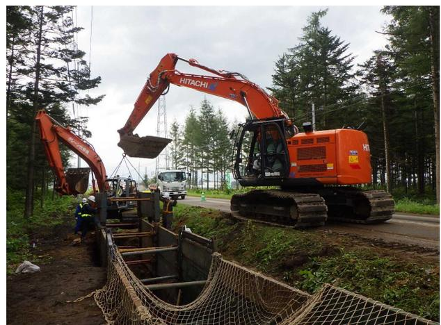
写真-2 簡易土留め工法施工状況
