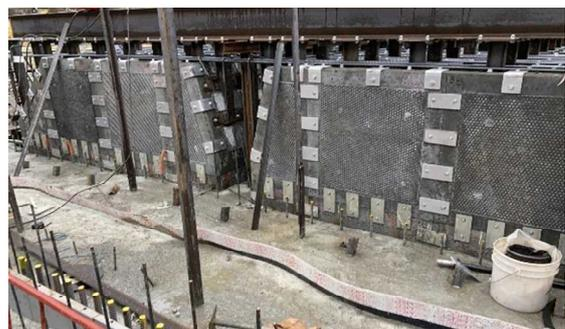
写真-5 ボルトとプレートによる固定
