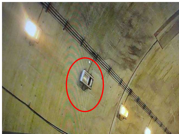
写真-7 一般国道229号神威岬トンネルL側No.9
