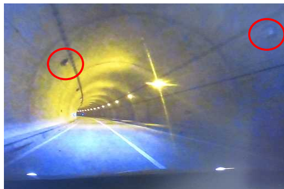
写真- 3 神岬トンネル(汎用カメラ)
