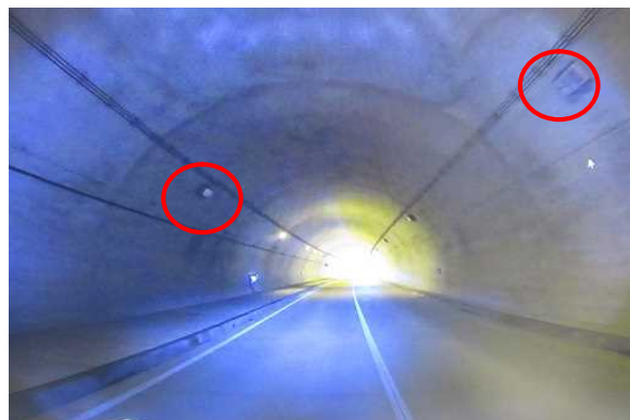
写真- 4 神岬トンネル(360度カメラ)
