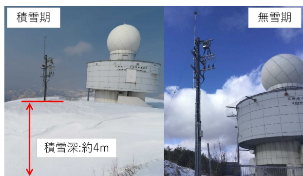
写真-4 観測所付近の積雪状況
