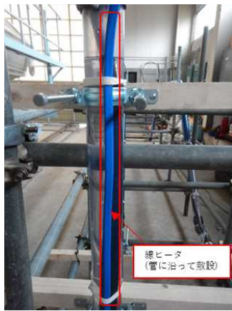
写真-2 線ヒータ敷設状況
