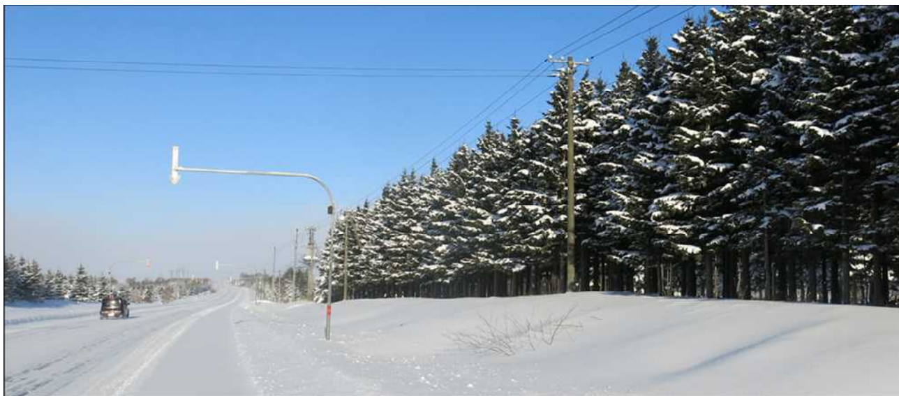
写真-1 一般国道238号 浜頓別町 山軽防雪林の現況(稚内市に向かい撮影:令和3年1月)
