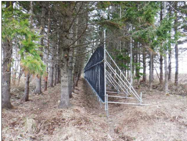
写真-9 補助柵を設置した事例(令和3年4月撮影)
